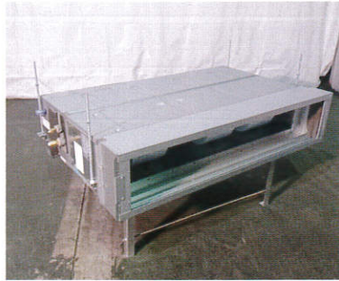
②接続ボルト取付
