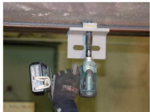
本締め(インパクトレンチ使用)
